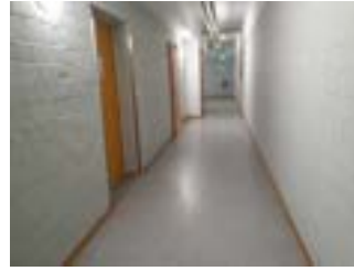
Flur von Treppe zur Bodega (UG)
